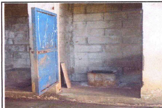
Foto 4: Limpieza general al baño Escolar.
